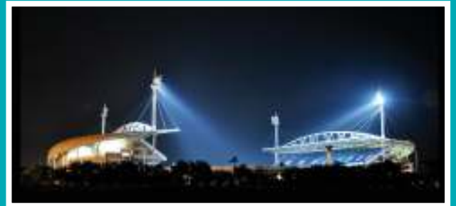
Hệ thống cáp tại sân vận động Cable system in stadium
