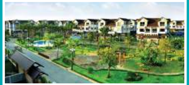
Hệ thống cáp tại khu đô thị Cable system in urban area
