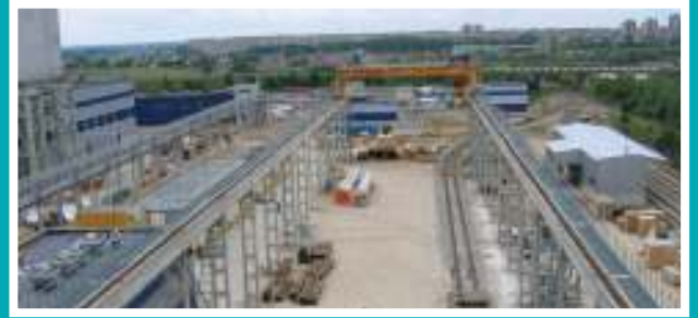
Hệ thống cáp ngầm tại nhà máy Underground cable system in factory
